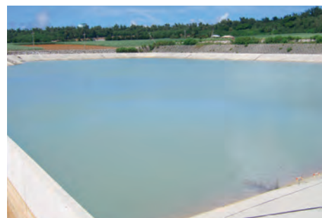
南大東村新東地区貯水池（沖縄県）
