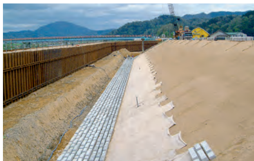
円山川施工中
